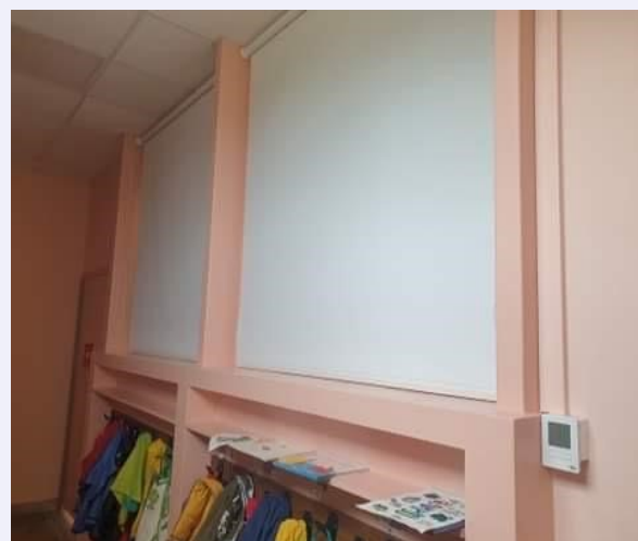
Installation de stores côté de la maternelle
