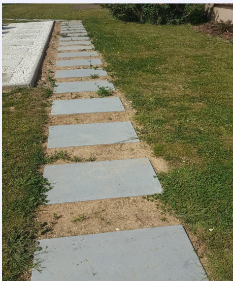
Pose des dalles à côté des cavurnes
