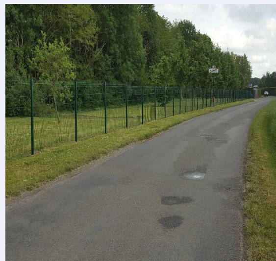
Pose d'une clôture rue des Aérostiers
