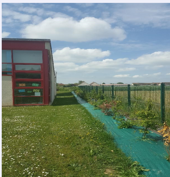
Pose d'une clôture et haie sur le côté de l'école
