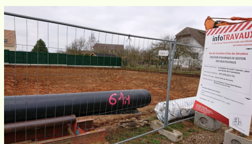
* Bassin de régulation avec gestion des eaux pluviales rue des Gravelots et des aérostiers
