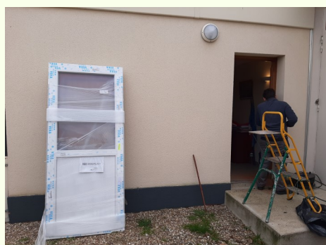
* Changement de 3 menuiseries et réparation des ouvertures de l'école
